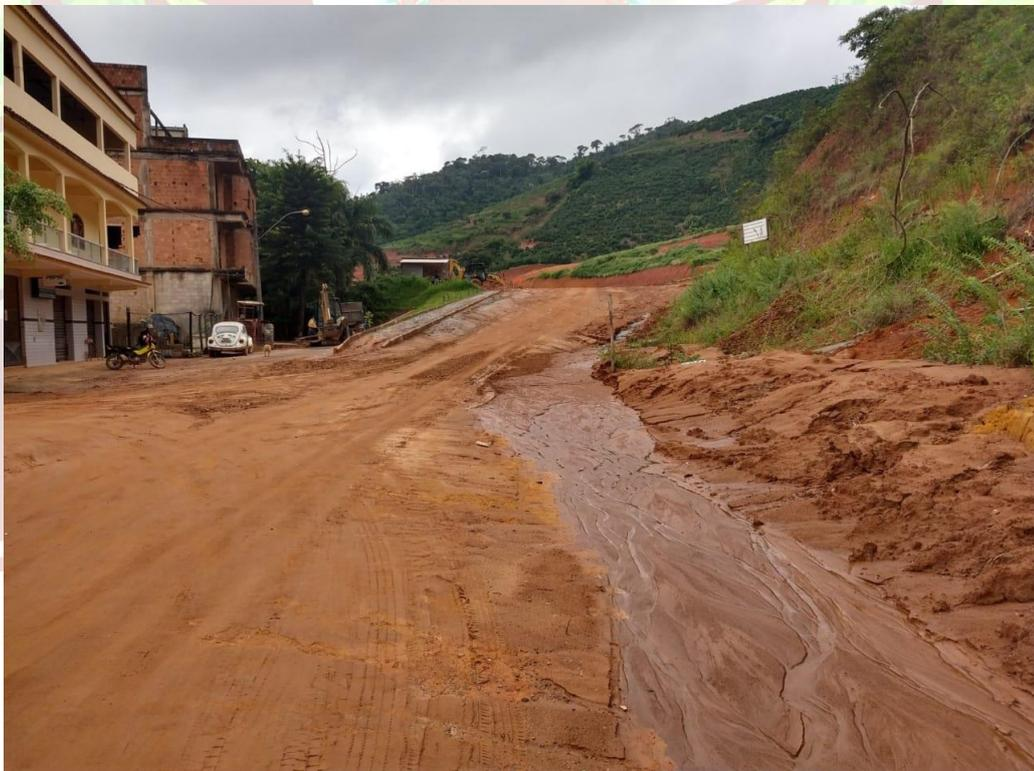
**Foto 08: visão a partir da estaca 18 apresentando ao fundo trecho onde será necessário fazer escavação com profundidade de 1,60m para realizar aterro com compactação Proctor normal.**
