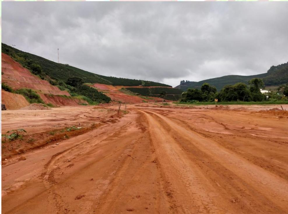
**Foto 12: estaca 50 onde será necessário realizar escavação com profundidade de 1,60m para realizar aterro com compactação Proctor normal.**
