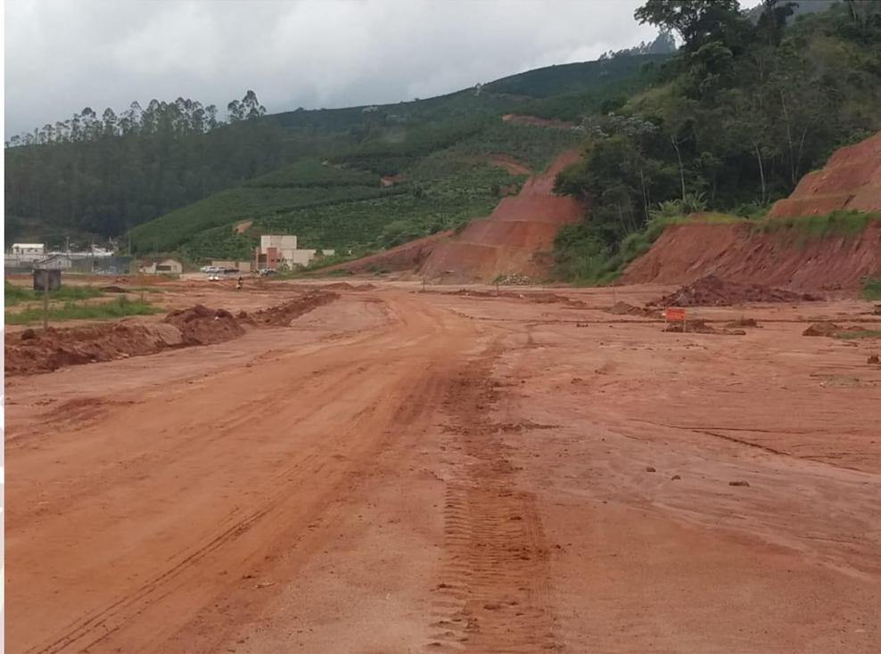
**Foto 11: estaca 26 onde será necessário realizar escavação com profundidade de 1,60m para realizar aterro com compactação Proctor normal.**
