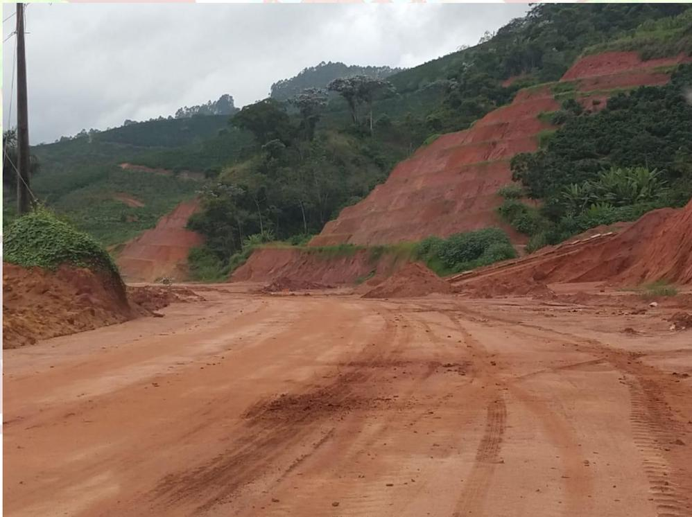
**Foto 10: estaca 24 onde será necessário realizar escavação com profundidade de 1,60m para realizar aterro com compactação Proctor normal.**
