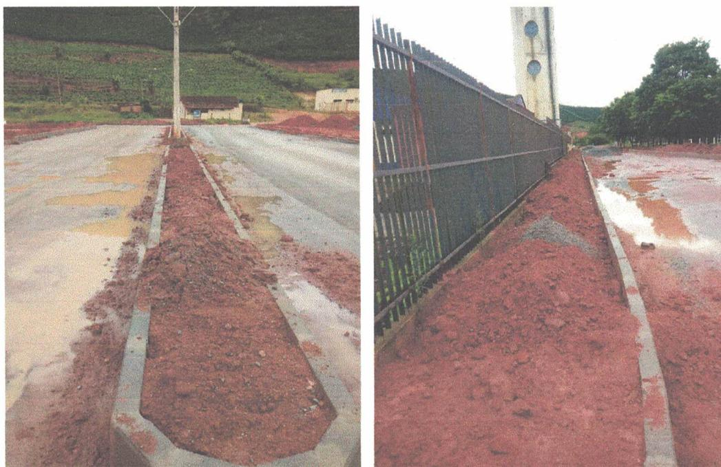
Foto: Nas imagens acima pode ser observado alguns dos trechos necessários a realizar o serviço de reaterro compactado, incluso nestes locais o transporte do material a uma dsitância média de 01 km.
