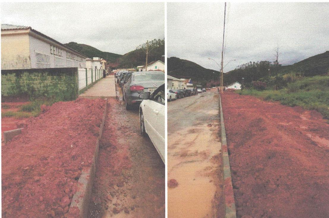
Fotos: Nas imagens acima pode ser constatado a necessidade de executar uma barreira com meio fio dos lados opostos a rua para execução da calçada, uma vez que nestes locais não há muros ou barreiras físicas que permitem executar a calçada sem este serviço.
