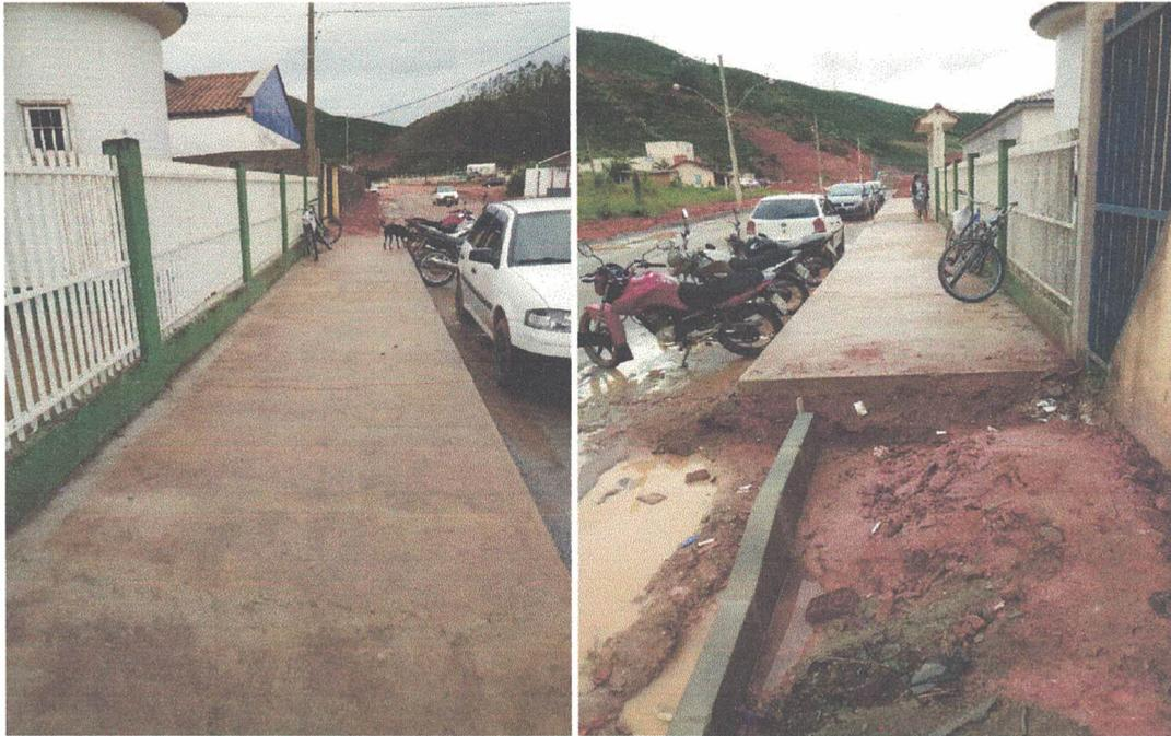
Foto: Nas imagens acima observa-se a calçada em frente a APAE com trincas, não atende as normas de acessibilidade e está invadindo a área projetada para a rua.
